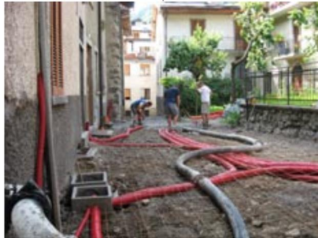
Nel contempo si è dato anche il via alla sostituzione delle tubature relative ai servizi dell'acquedotto e degli scarichi fognari.
